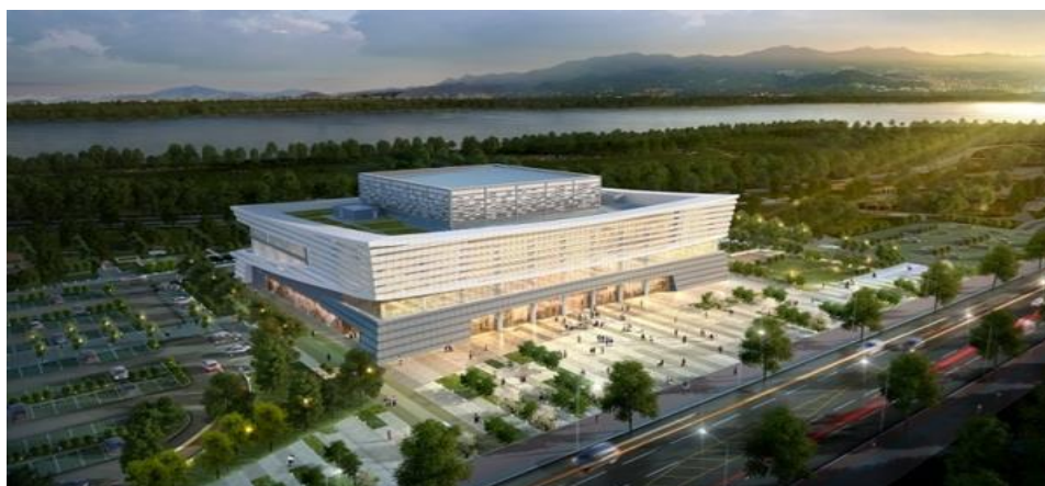
ภาพโครงการก่อสร้างอาคารหอสมุดรัฐสภาแห่งใหม่ ณ นครปูซาน (ระยะเวลาก่อสร้าง พฤษภาคม ๖๒ – ธันวาคม ๖๓)
