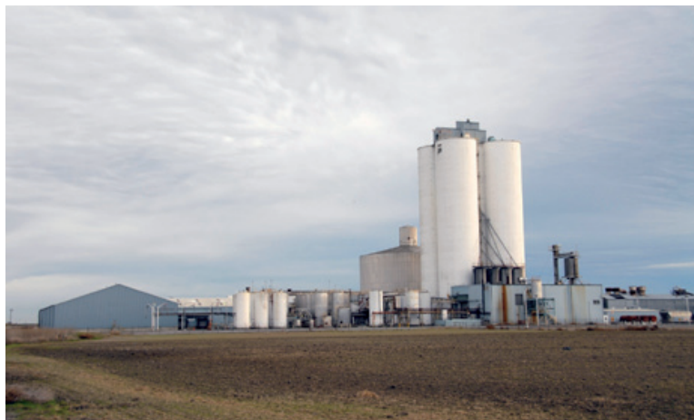
โรงไฟฟ้าชีวมวล
