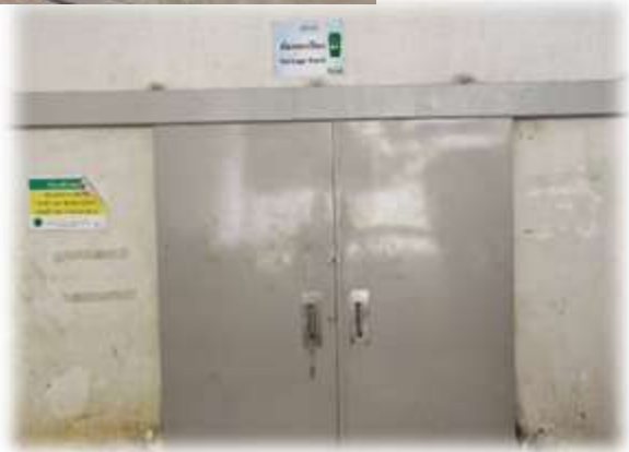
ห้องพักขยะ อาคาร F
