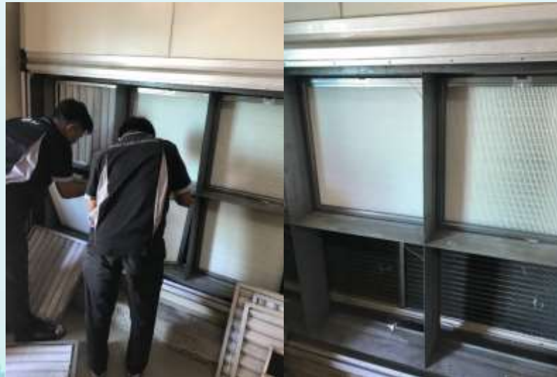
ติด Filter กรองฝุ่น PM2.5
