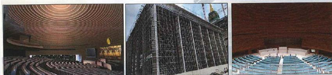
ภาพถ่ายงานก่อสร้างห้องประชุม ส.ส.
